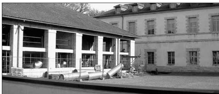
Travaux d'aménagement sur le site de la Nive
