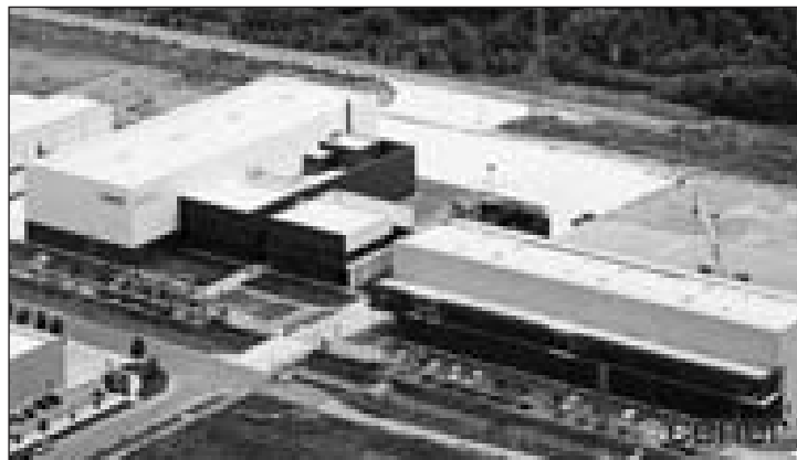
Le Laboratoire d'essai d'aérogénérateurs à Zangotza
