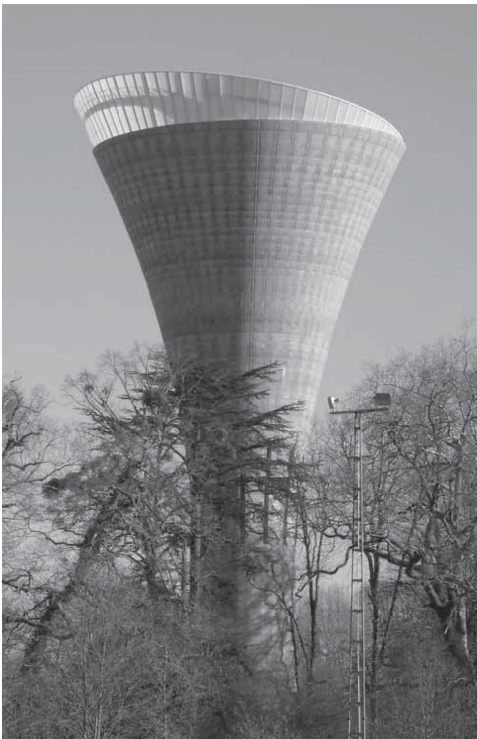
Le château d'eau de Mousserolles à Bayonne. La Communauté d'agglomération Pays Basque a pris la compétence eau et assainissement, jusque-là assurée par des dizaines de syndicats et de communes.
