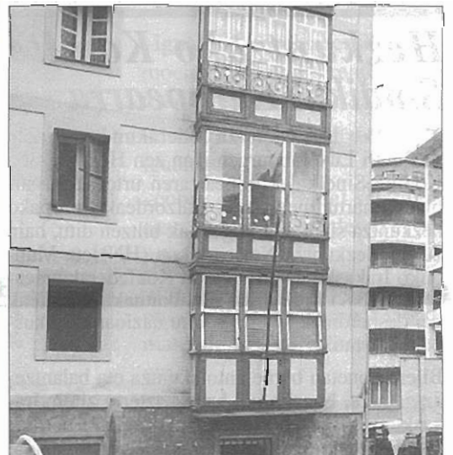
Al fondo, el nuevo local de Eibar, cuando se encontraba en fase de construcción.
