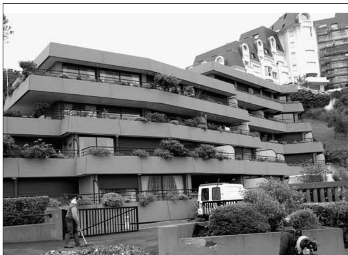
La Roseraie II: première tranche de 17 logements sur 108
