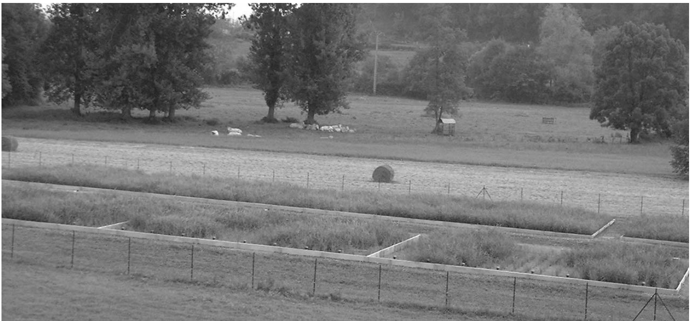
Assainissement des eaux usées écologique et performant : c'est à Alos qu'on trouve la seule réalisation en Iparralde faisant appel au génie végétal ! Les roseaux utilisés pour l'épuration des eaux usées assurent entre autre l'intégration paysagère de la filière d'épuration et une pédagogie environnementale.
