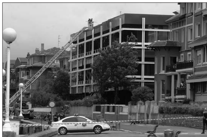
Façade du club maritime de Getxo après l'attentat d'ETA
