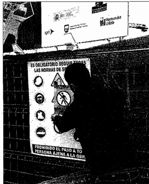
Colocación de carteles en una obra de Hernani. GARA
