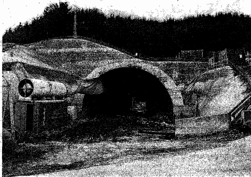
Obras del TAV a su paso por Ezkio-Itsaso, que recibió en septiembre otro impulso de Lakua. DE GALILEA
