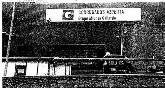
Exterior de las instalaciones de Corrugados Azpeitia. FOTO: JAVI COLMENERO
