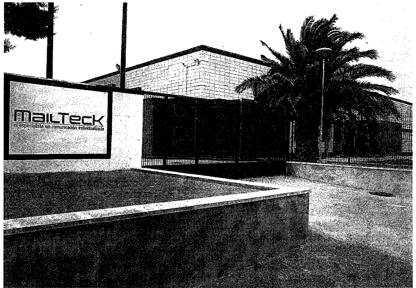
Imagen exterior de las instalaciones de la empresa Mailteck de Buñuel.
