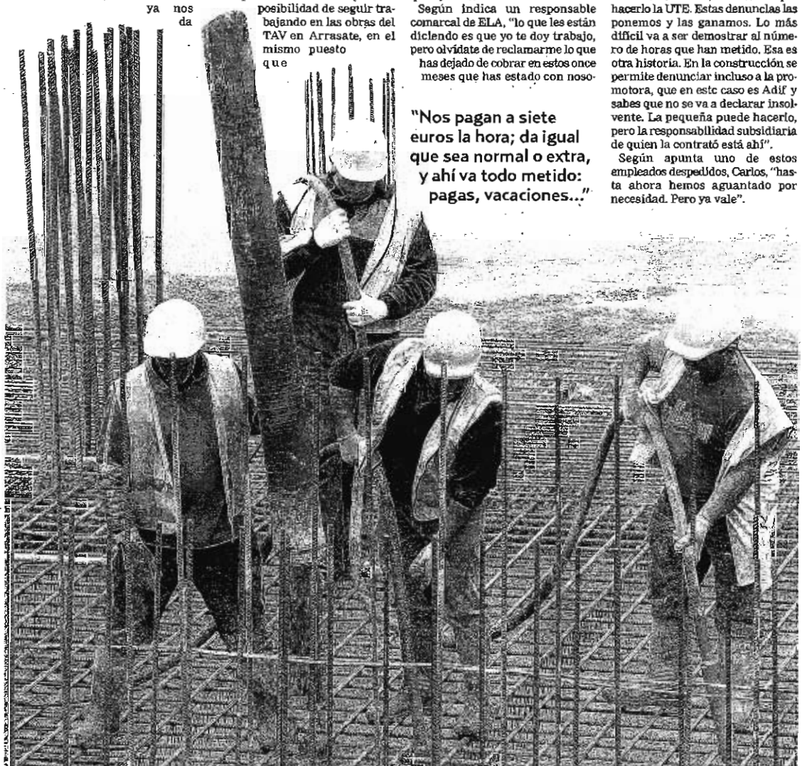
Un grupo de encofradores trabaja en una importante obra que actualmente se está llevando a cabo en Gipuzkoa. FOTO: RUBEN PLAZA
