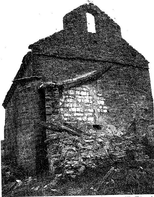
Agrietada cabecera de la ermita de San Martín de Guerguitiáin. El templo es uno de los mejores ejemplos del románico en el valle de Izagaondoa. DN
