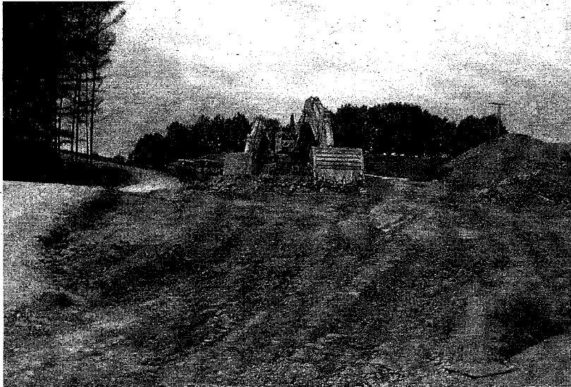
Imagen de archivo de las obras de la variante Irurita-Elizondo.
