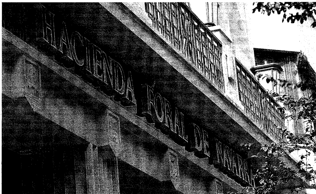
Edificio de la Hacienda foral navarra.
