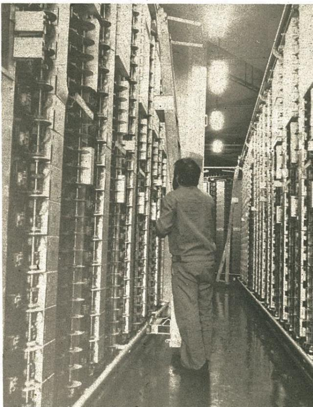
Interior de una central en el que un trabajador está "siguiendo tráfico" en un equipo sistema rotari 7A2
