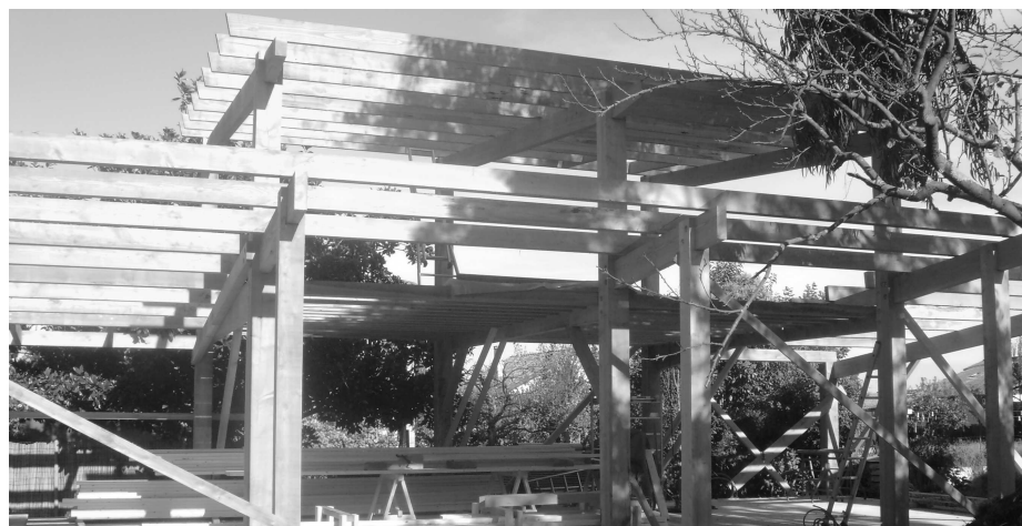
Maison en construction : vue de la structure en bois
