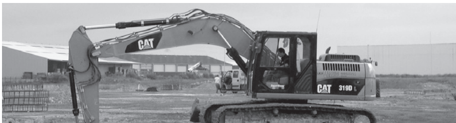
Pelles et débroussailleuses ont décapé les terres bordant l'A63
